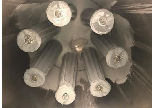
Figura 13- Estufa com os filtros montados após o primeiro enxaguamento
